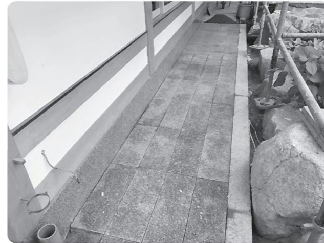
敷石および縁石の加工・設置
