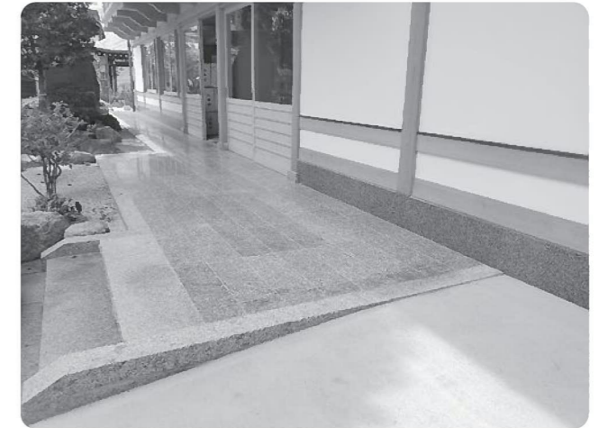
北門側階段・袖石および敷石
