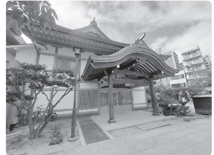
スロープ、向拝縁石・敷石、入口階段、景観工事
