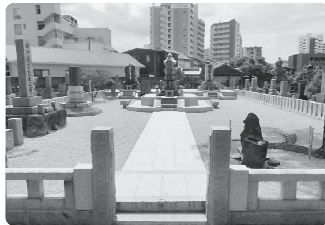
玄洋社墓地整備 竣工
