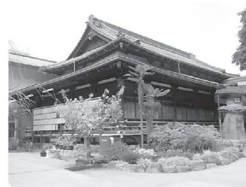
解体前の写真
