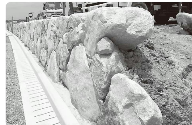
土台の高さは70cmから1mの高さがあり、今回の積み方は野面積みになります。野面とは表面が自然のままということで、石本来の表情が見える積み方です。
