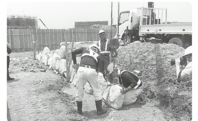
一つ一つ丁寧に積んでいきます。石積みは大小の石材の組み合わせで美観と強度を考え熟練の技で仕上げます。
