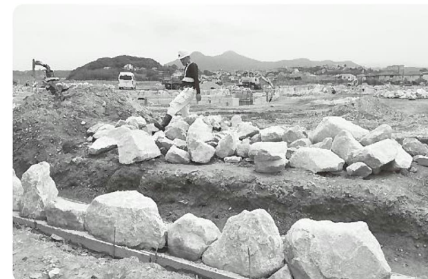
使用する積み石は福岡を代表する耳納連山より採石される耳納石です。積む前に、土台の高低差に合わせて石の選別から始めます。
