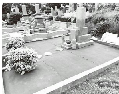
防草シート敷き
