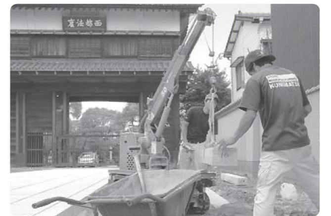
慎重に縁石を据付
