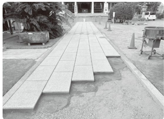
参道新設工事中
