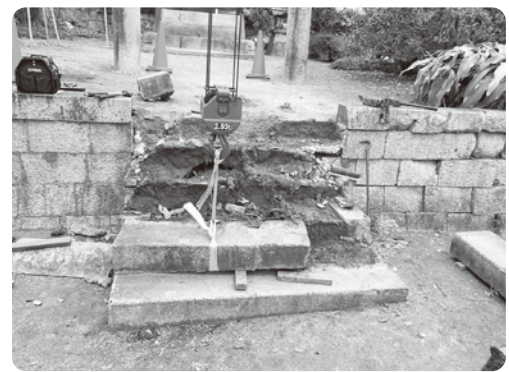
境内階段改修工事
