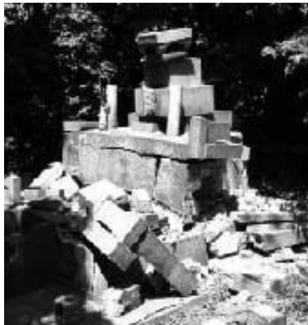
▲棹石のずれ、墓前灯籠の倒壊がみられます。棹石が90度回転してしまったお墓もありました。(福岡市近郊の霊園)
